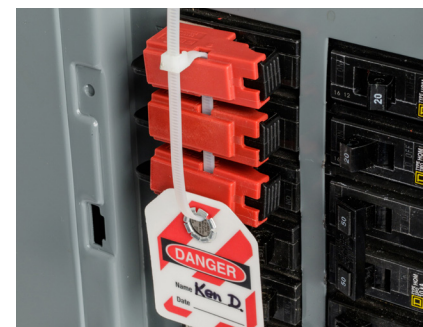
Los dispositivos para interruptores de 120V se pueden colocar en interruptores juntos, lo que permite que se pueda hacer múltiple etiquetado al mismo tiempo.
